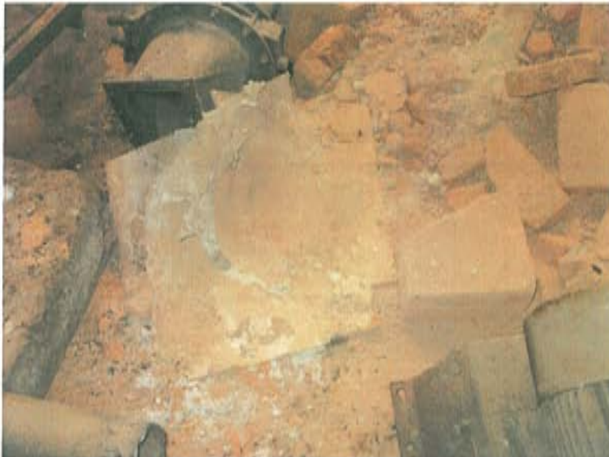
Figura 4-3: Deșeurile de cărămizi amestecate cu plăci de azbest de la demolarea unor cuptoare din hala FBB
