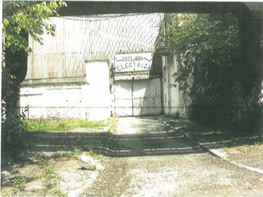
Figura 4-1: Imagine exterioara cu pereti laterali la hala fostei sectii OE1
