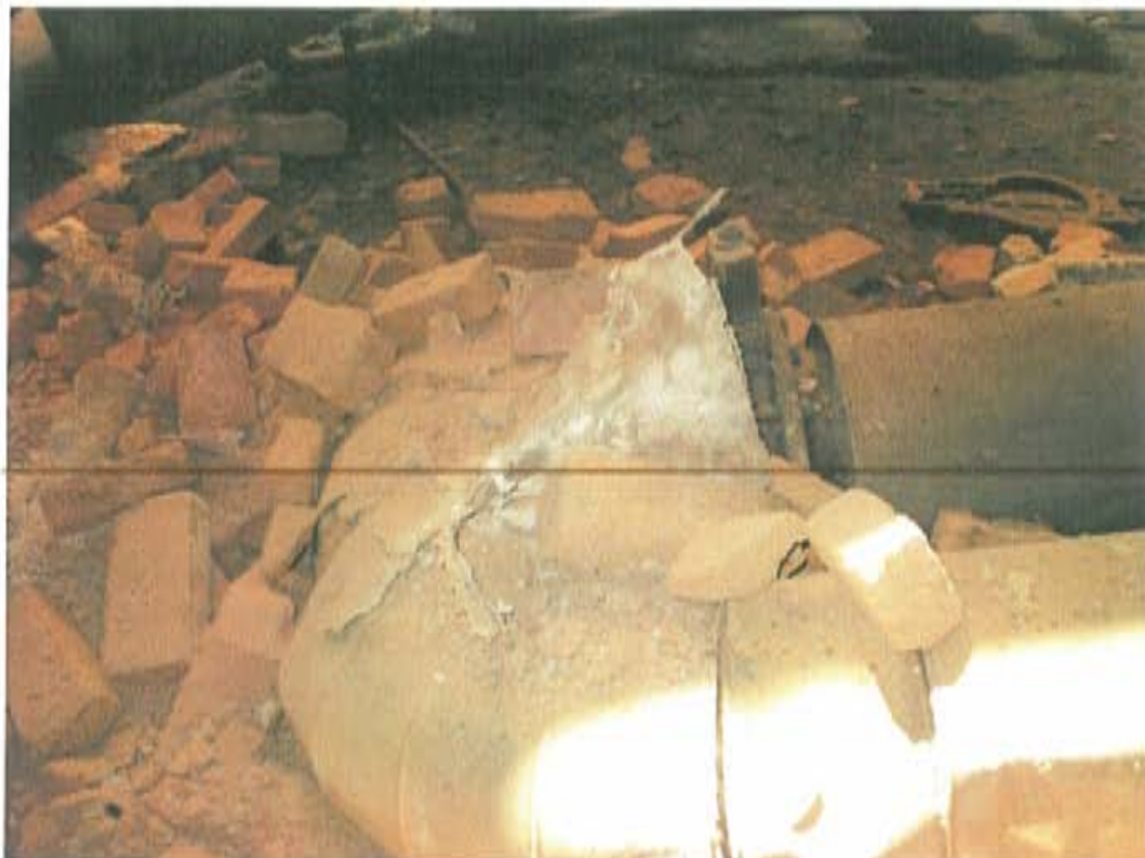
Figura 4-4: Deseuri amestecate de la demolarea unor cuptoare din hala FBB
