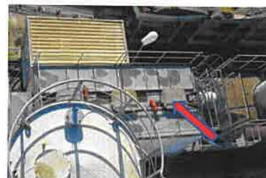
Mecanisme curatare filtru
