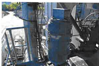
Rezervor tampon de aer comprimat – stare buna
