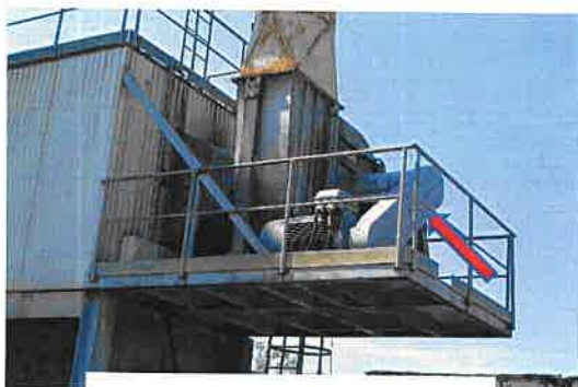
Curele antrenare ventilator
