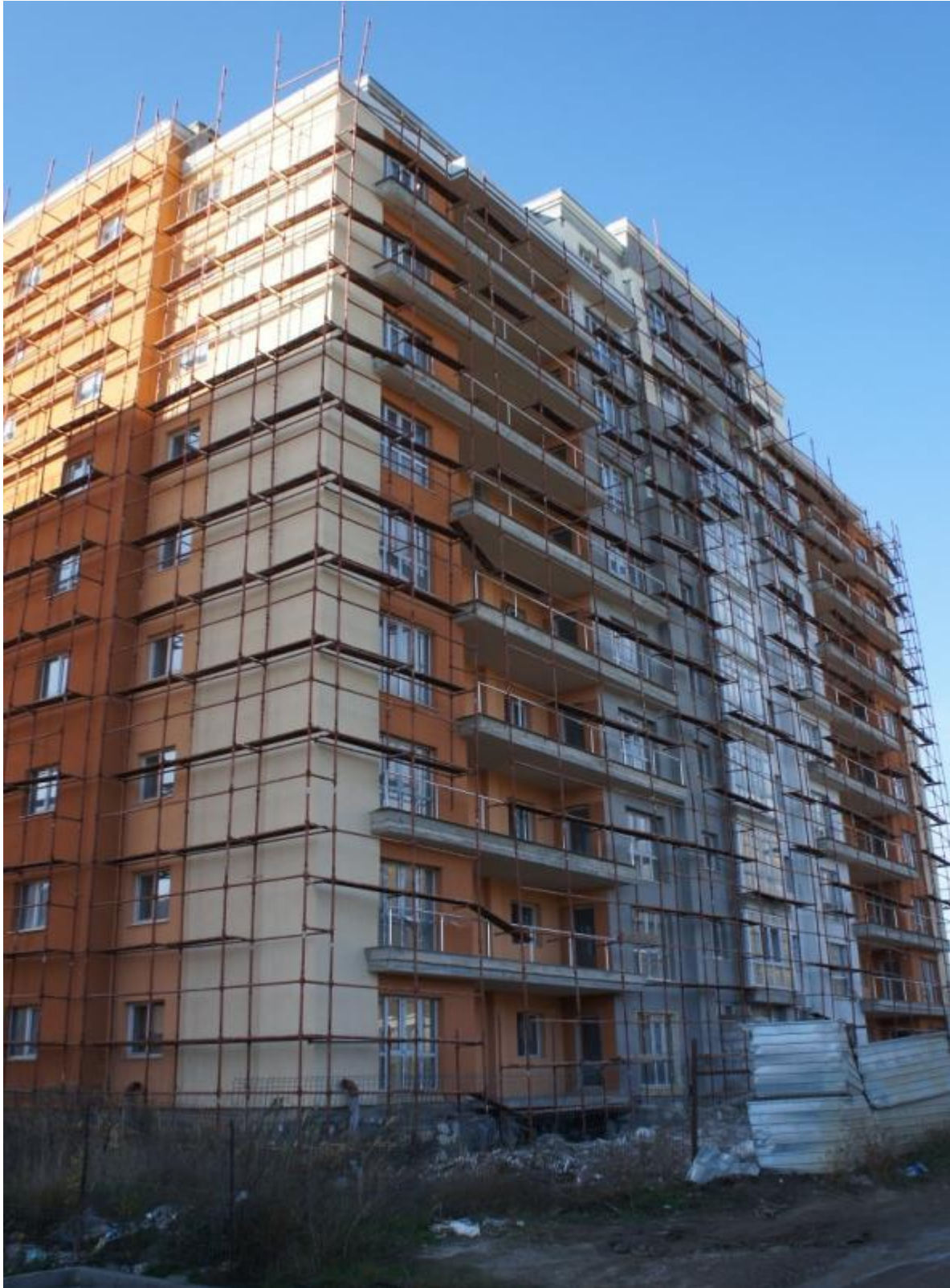
Bloc B10 –in constructie
