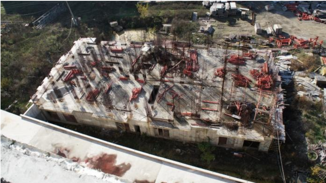
Bloc B9 –in constructie
