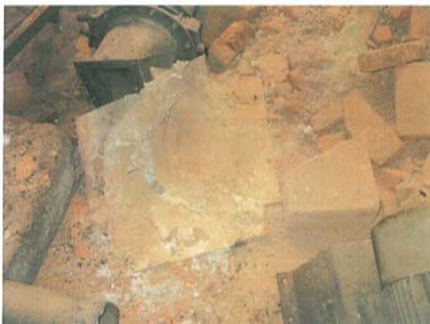
Figura 4-3: Deseuri de cărămizi amestecate cu plăci de azbest de la demolarea unor cuptoare din hala FBB
